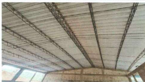
Foto 2: Sustitución de costanera de metal.
