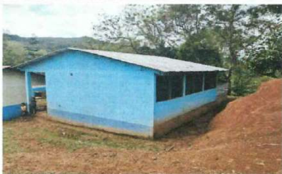
Foto 1: Cambio de lamina por lamina troquelada
