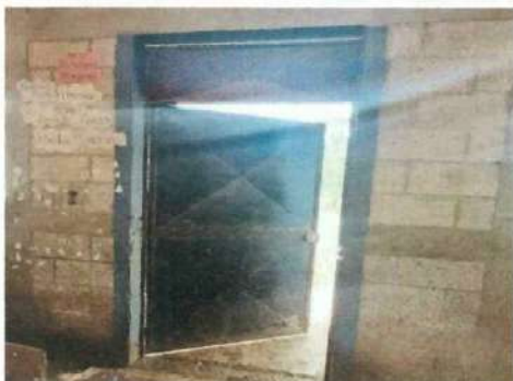
Foto 3: Sustitución de puerta de metal con chapa incluida.
