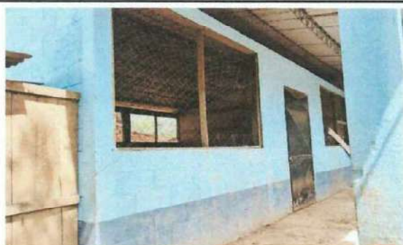
Foto 5: Aplicación y cambio de pintura en pared exterior e interior.
